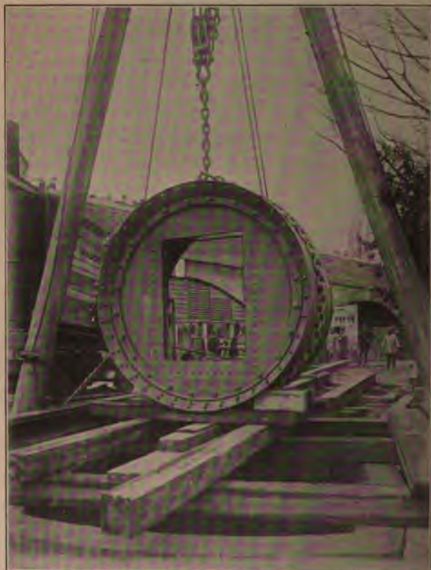
Fig. 323. — Vue de l'avant du bouclier.
